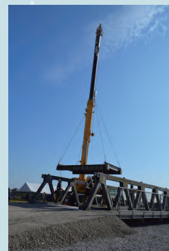
【応急組立橋設置】
