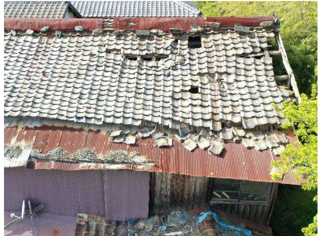
50点 （屋根が著しく変形したもの）
