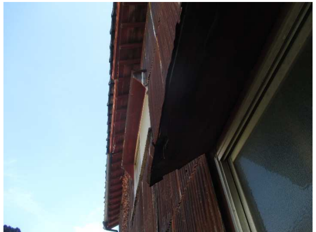
10点 （雨樋がないもの）
