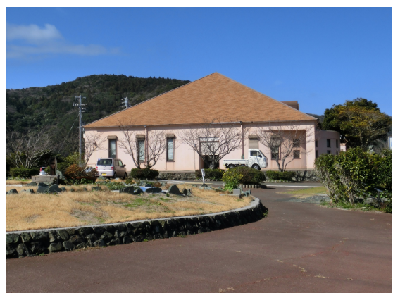
東面からの建物状況
