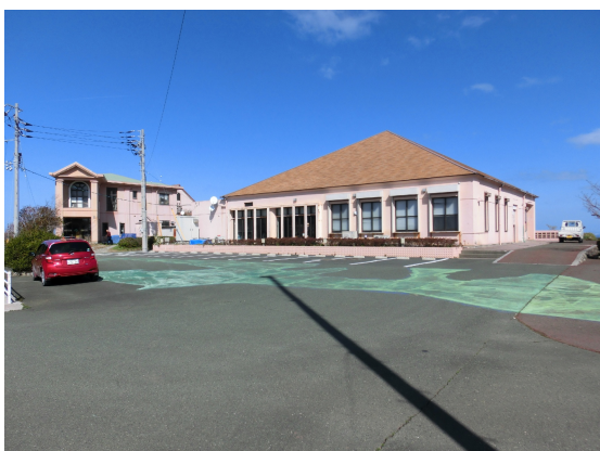
南面からの建物状況
