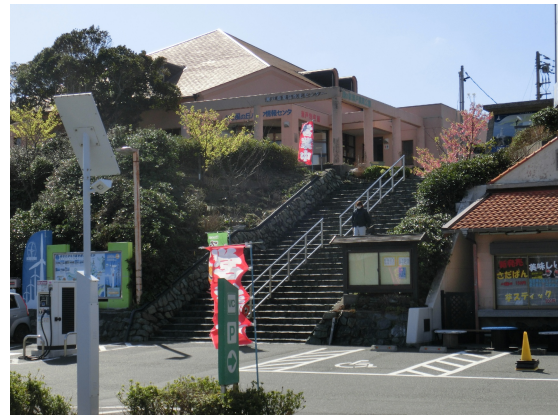
駐車場からの建物状況
