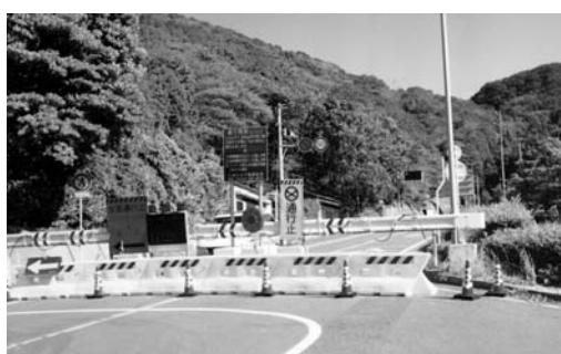
名取トンネル通行止箇所(三崎側)
