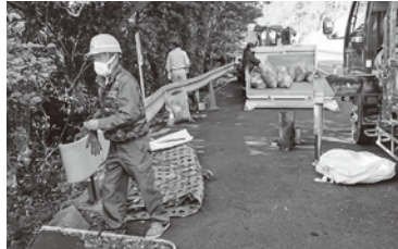
【作業中の様子】
