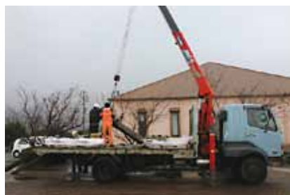
新たなシンボルとなる風車が到着。 大荒れの天気の中、設置しました。
