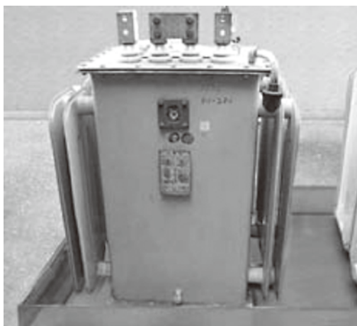
高圧トランスの例
