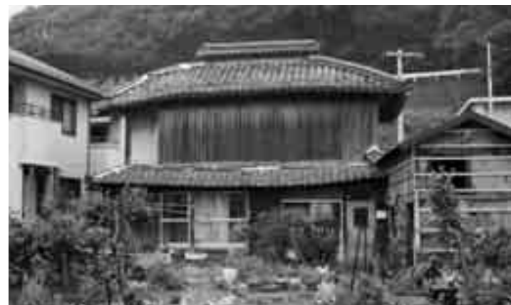
お蚕を飼っていた古い家(塩成地区・2012年3月撮影) 屋根の上に越屋根という小さい屋根が付き、通気をよくする構造になっている。
