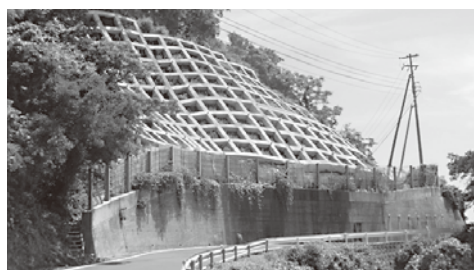
（町道宇和海線道路改良工事）
