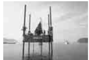
工事施工中イメージ
