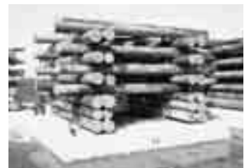
間伐材を利用して製作された木製増殖礁
