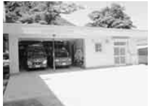
第10分団6部(二名津)消防ポンプ格納庫新築工事
