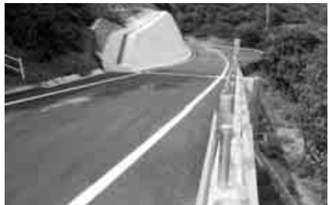
町道大成鳥津線道路改良工事
