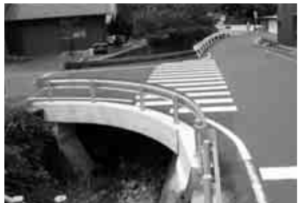
町道三崎名取口線（二名津）橋梁補修工事
