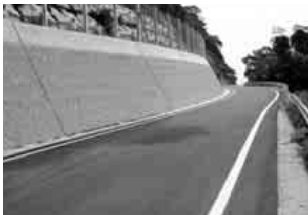
町道宇和海線道路改良工事
