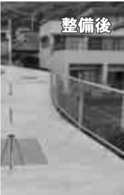
転落防止のため設置しました。
