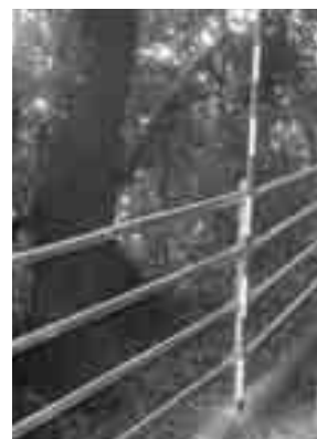
手すりを設置し、高台 落防止を図りました。
