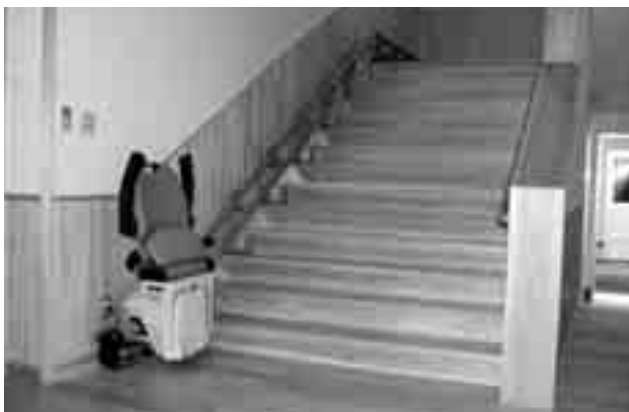
階段に設置された昇降機
