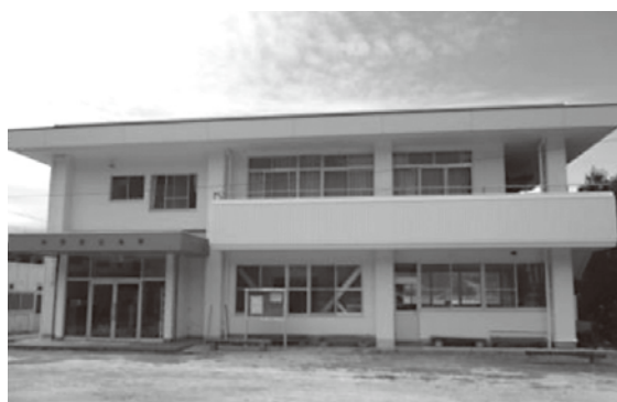
地区集会所耐震補強工事
