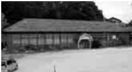
写真：塩成小学校の廊下(上) 旧正野小学校(下) (2007年9月撮影)
