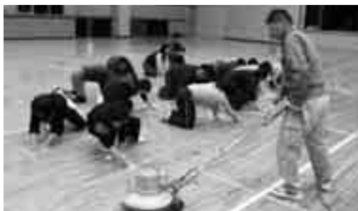
クリーナーで汚れをはく離しそれをふき取る作業
