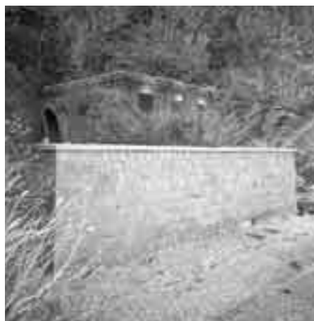
▲旧平磯水底線陸揚室〔平磯〕竣工 昭和2年
