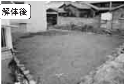
解体撤去により安全性を確保
