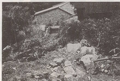
長雨により被害をうけた家屋
