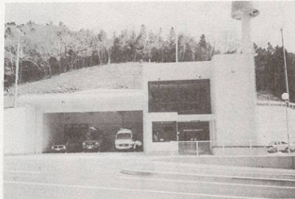
完成した第1分署（瀬戸町神崎）
