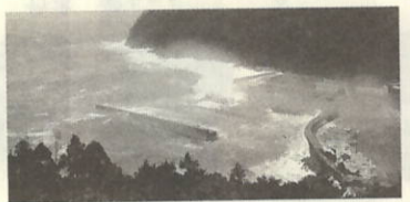
防波堤災害復旧工事を行う足成漁港
