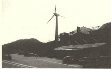
台風16号により風車の羽根が損傷
