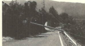
台風18号により電柱が倒れ、県道が通行止
