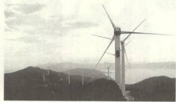
10月1日の運転開始を目指す風力発電施設
