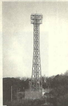
3月 小島地区山頂部に移動通信用鉄塔建設 続いて田部・神崎・高茂地区を整備中。これにより携帯電話の不通地区解消
