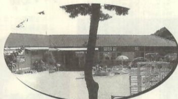
10月 三机保育園改築工事着工 10月26日起工式。15年3月完成予定
