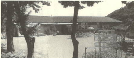
改装が進められる三机保育園（9月着工、来年2月完成予定）
