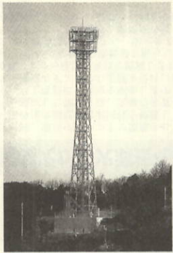
小島地区山頂部に整備された通信鉄塔
