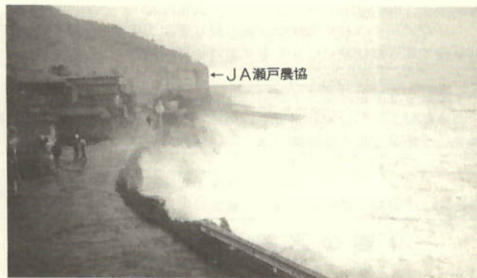
護岸植波状況
