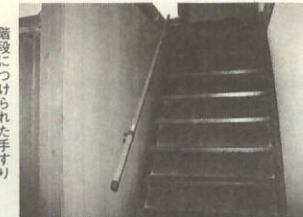
階段につけられた手すり
