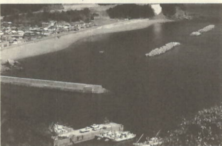
◀塩成漁港海岸保全施設整備事業 高潮より生命財産を守るため、離岸堤を 継続実施していきます。
