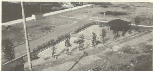
▲足成漁港公園整備
