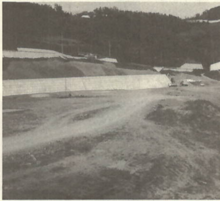
造成が進む用地
