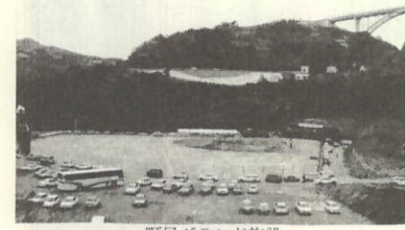
町民グラウンド施設
