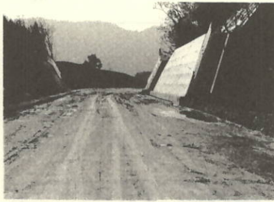
舗装を残して出来上がり(川之浜附近)
