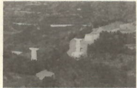
▲観光開発の核… (工事中の塩成大橋)
