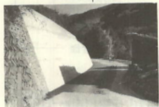
3. 町道大久神崎線道路改良 4.0ヶ所 L=165.9m 事業費 26,205,000円
