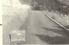
2. 町道川之浜アワタニ線舗装工事 L=670m 事業費 6,979,000円
