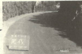
10. 町道瀬戸頂上線舗装工事 L=700m 事業費 8,010,000円
