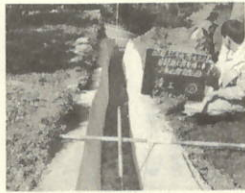
排水路整備事業(田部) 水路工 3ヶ所 L=446.35m 事業費 8,311,000円
