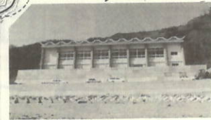
5. 四ツ浜地区体育館 鉄筋コンクリート 2F建 A=978.2m 2 事業費 119,480,000円
