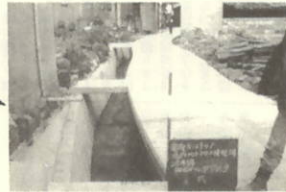
1. 排水路整備事業(塩成) 水路工 2ヶ所 L=235.9m 事業費 7,805,000円
