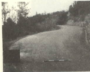
8 町道みもとり大久線舗装新設工事 L = 1,327.0 m W = 4.0~8.6 m 事業費 24,238,000円
