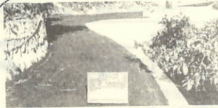
7 町道大久ヒラへ線舗装工事 L = 2678.2 m W = 2.2~11.5 m 事業費 28,067,000円
