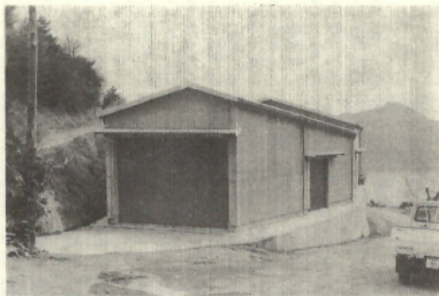
神崎柑橋集荷所完成
