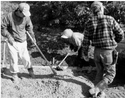
園内作業道を設置
