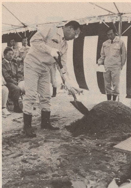
祈願祭でくわ入れを行う工事関係者
