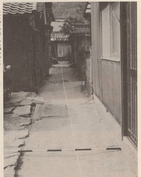
簡易下水道として整備される中浦
