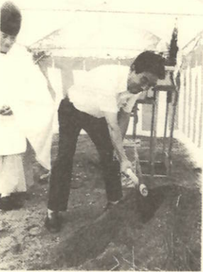
福田町長のくわ入れ、工事の無事を祈りました。
