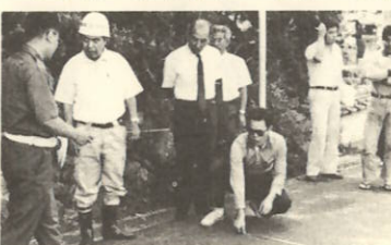
路側帯を設けるため道幅などを測定
