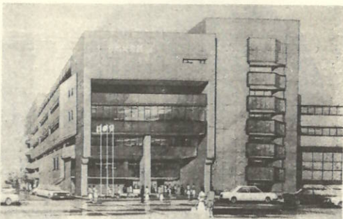
エレベーター2機、レダー光線を使った警備装置など近代的な設備を数多く備えています。
