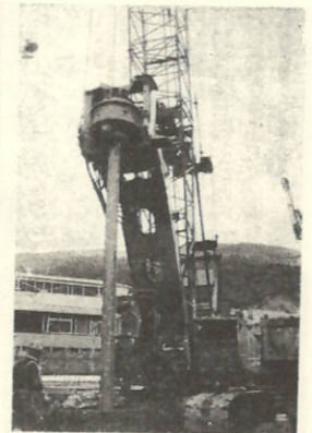
騒音、振動防止対策から新工法を採用
