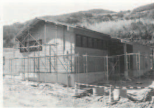
▶10月中旬頃完成予定の仮設温泉風呂施設
