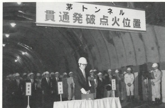
◀7/2町道湊浦伊方越線の「茅トンネル」貫通式
