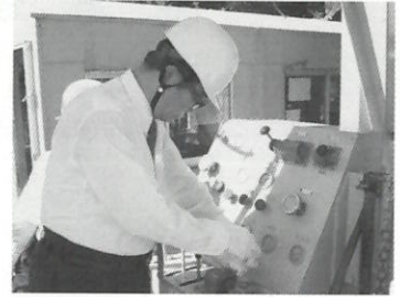
▲掘削機の運転スイッチを押す 中元町長
