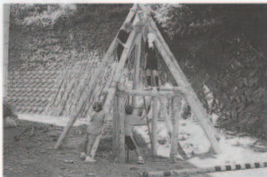
骨組みの完成
