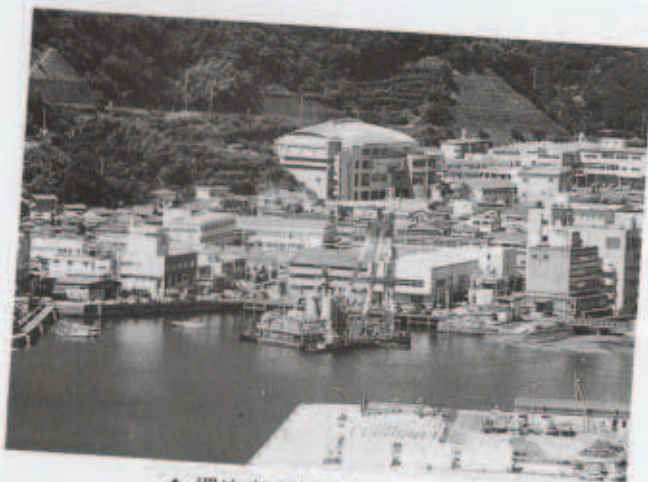
▲埋め立てが始まる伊方港
