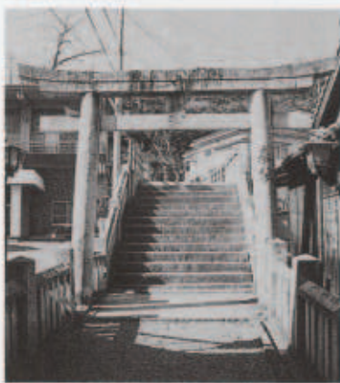
鳥居の形式は、二本の柱と笠木と貫を単純に組み合わせたものが神明鳥居、笠木が五角形に加工されたのが伊勢鳥居、貫が柱の外に突出たのが鹿島鳥居、笠木に反りをつけ、笠木と貫の間に額束を入れたのが明神鳥居、柱を角にしたのが住吉鳥居
